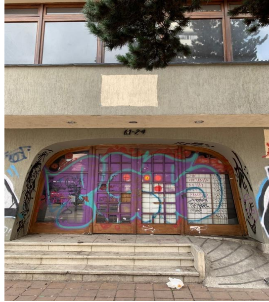
Entrada al antiguo restaurante Pozzeto, barrio Chapinero Bogotá.
