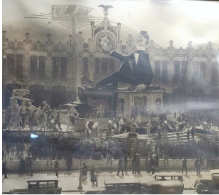
Figura 136. Falla Estación del Norte. Vista general.
