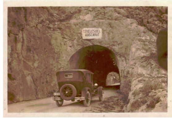
Fotografía de la época. Túnel del Mascarat
