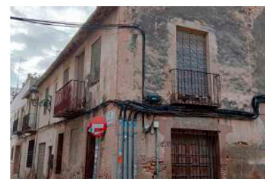
[Fig. 43] Edificio donde se situaba la carpintería del señor Orbaiceta en Burjassot (2024).
