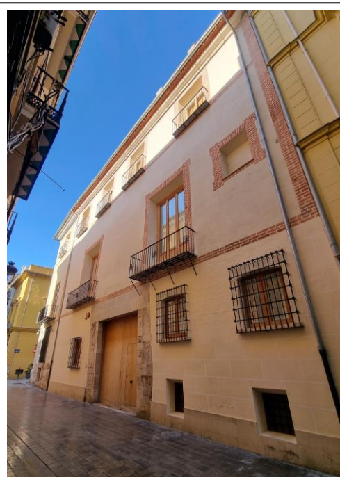
Actual façana original del palau dels Català de Valeriola en el carrer dels Catalans (ara c/ de Samaniego).
