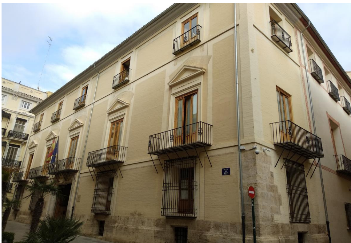
Façana principal del Palau dels Català de Valeriola en la plaça de Nules
