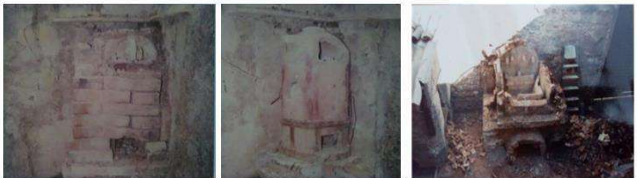
Fig.98.Desmontaje del horno de pruebas marca Curcuny conservado en el MCM
