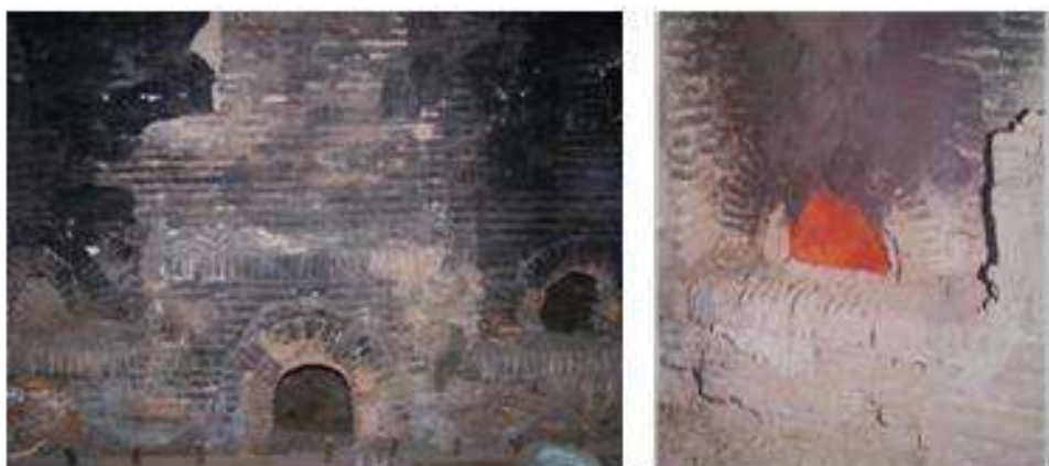
Fig. 94. Bocas de alimentación hornos de reflejo vista desde la leñera.
