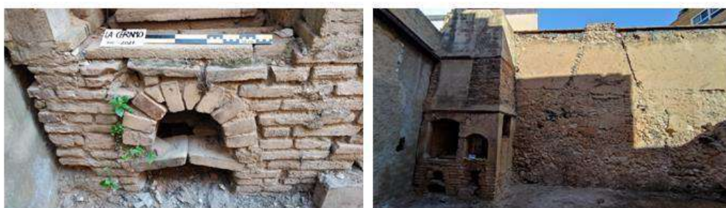
Fig. 96. Horno para calcinar reflejo.
