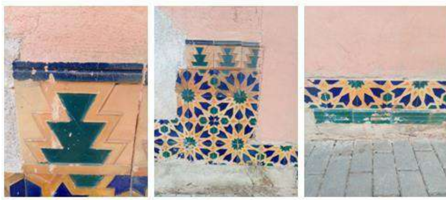
Fig. 60. Detalles neoarábigos en el zócalo de la fachada. Fuente propia.
