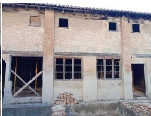
Imagen actual (2021) Vanos en nave obrador originales
