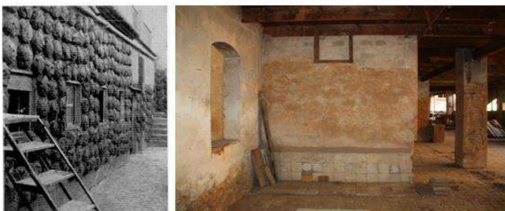
Fig. 76. Estany con tortas de barro en Fábrica de Manises V. Rosello y estany con huellas de las tortas de barro en la nave obrador de La Ceramo.
