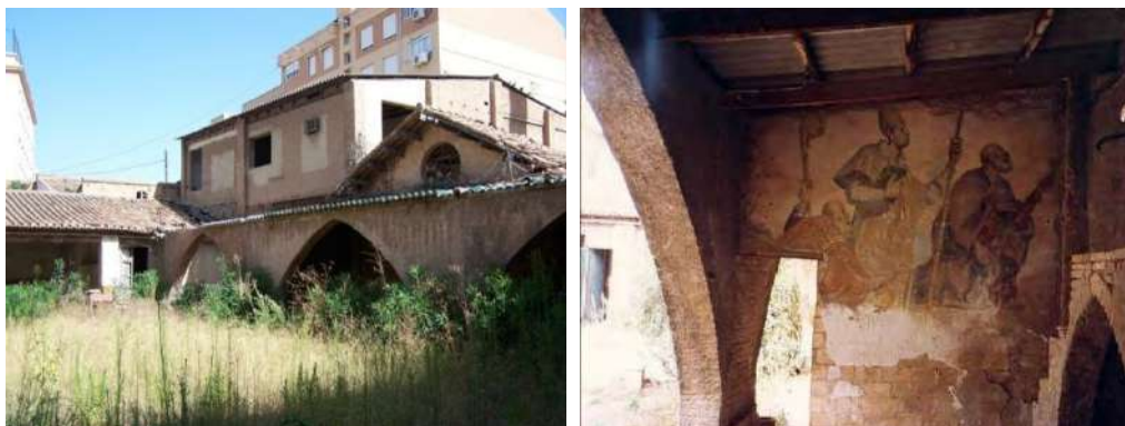
Fig. 51. Porche adosado a nave central de origen. Pinturas de José Ros Ferrandis interior del porche. Archivo Pérez Camps.
