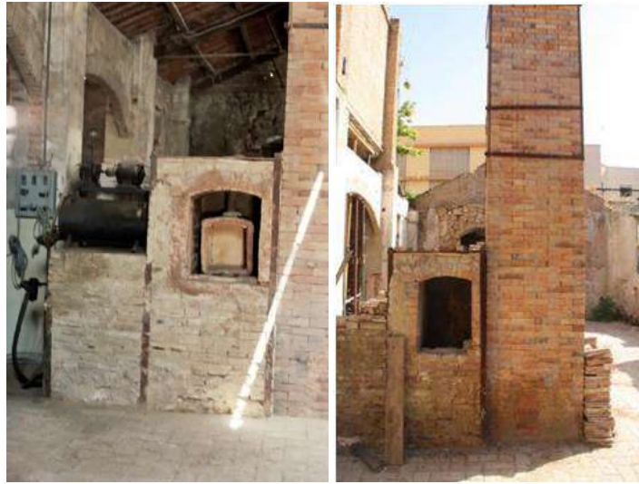
Fig.72. Detalle chimenea de ladrillo década de 1980 y en la actualidad. Archivo Pérez Camps y Fuente propia.
