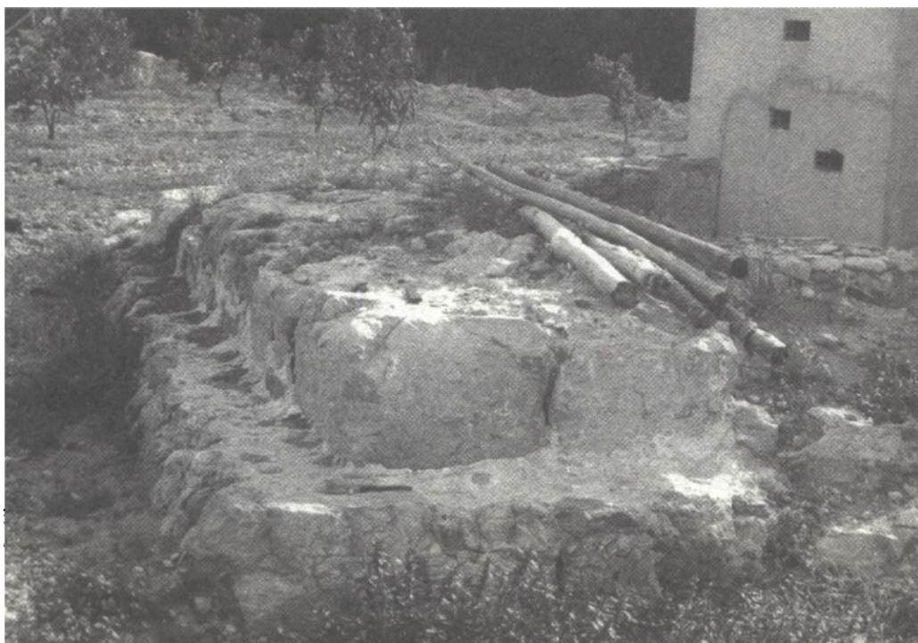
Figura 236. Fotografia del pou de la torre 1575
