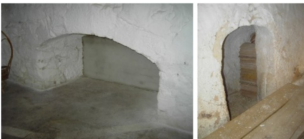
Figura 225. Muralla en les cases del carrer Major 1550
