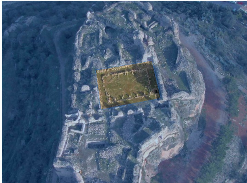
Figura 251. Claustre del convent del castell de Montesa. En la vista aèria es pot apreciar el disseny geomètric de les vies que divideixen el pati del claustre, en aquest cas dues vies principals que dibuixen una creu i dues vies secundàries de menor mesura que subdivideix els quadrants. Material inèdit.
