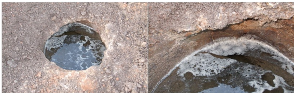
Figura 263. Dipòsit de la Ràpita de Quartons
