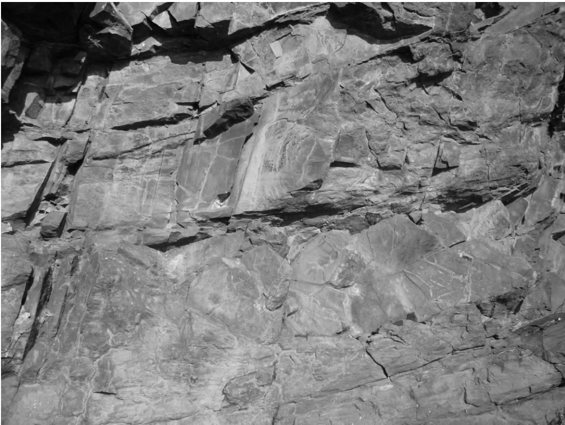
Figura 2.2.106. Vista general del Conjunto E, en el centro se sitúa la figura 6.
