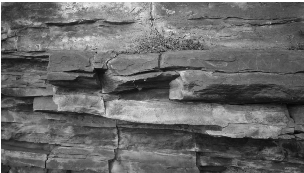
Figura 4.2.31. Observar las extracciones en la roca donde debería estar la pintura.
