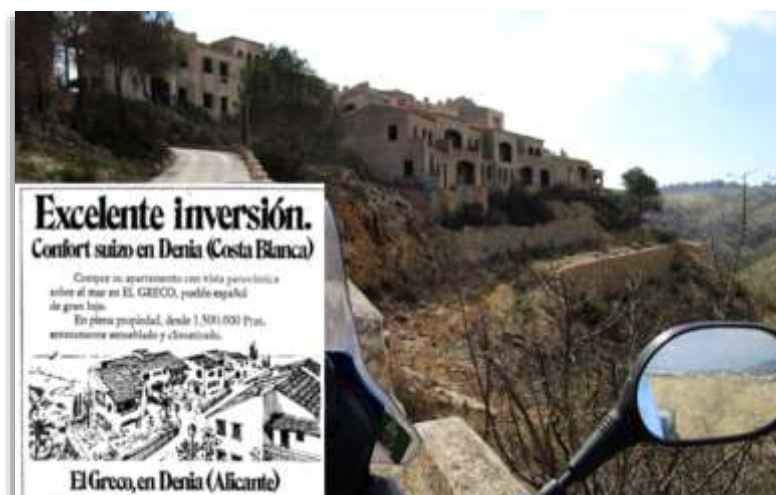
Fotografía 19: Ruinas de la urbanización “El Greco” en la Lloma del Castanyar. Superpuesto, el anuncio con que se publicitaba la urbanización en prensa. Fuente: https://www.lasprovincias.es/valencia/20080410/marina/demolicion-urbanizacion-greco-montgo-20080410.html
