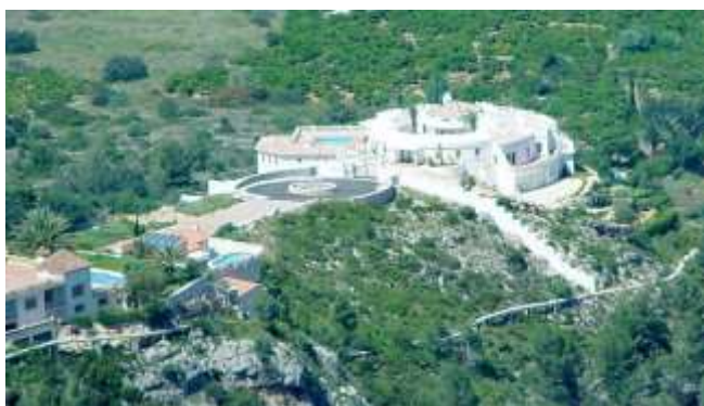
Fotografía 18: Chale en Marquesa 6, supuestamente ubicado en terrenos del MUP Montgó I y colindante con el Parque Natural, dispone de una situación privilegiada lo que le otorga un elevado precio en el mercado inmobiliario. Fuente: https://www.solairrealtea.com .
