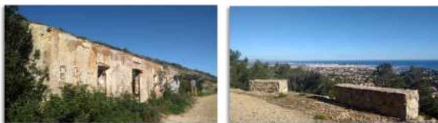
Fotografía 26: Arriba, a la izquierda: Casa de uno de los lotes en ruina, en el Camino de las colonias; arriba, derecha, vista de Dénia desde el mismo punto (Fuente: Dénia.com)
